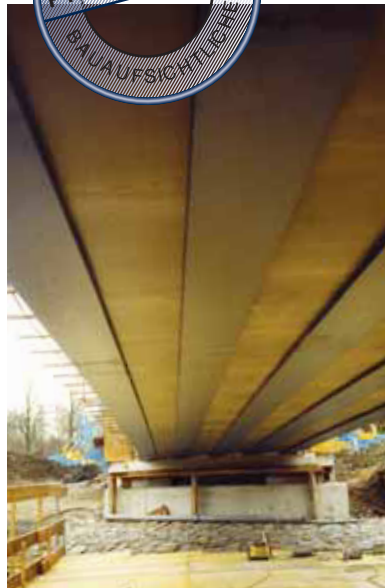
A/P Abdeckplatte – als verlorene Schalung
