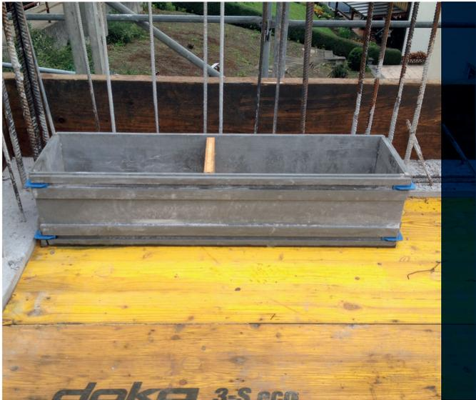
**ASS mit Holzdeckel Abdeckung** des Lochs als Durchtrittsschutz und zur Befestigung auf der Schalung mit einem Holzschott.
