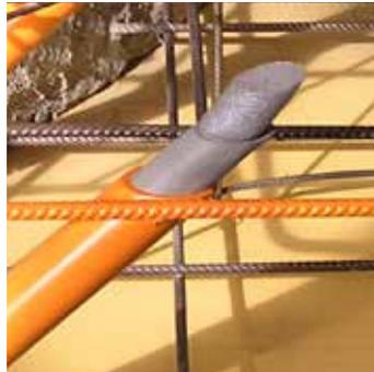
2. Kunststoffrohr auf Höhe justieren OK Beton.
