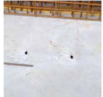
3. Nach der Betonage Schaumstoffstopfen raus ziehen.
