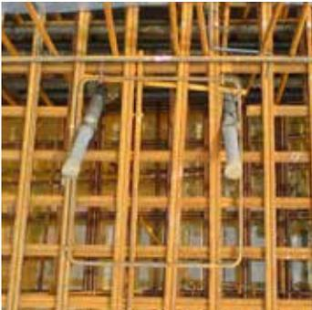
1. Anker Ausrichten und anbinden.
